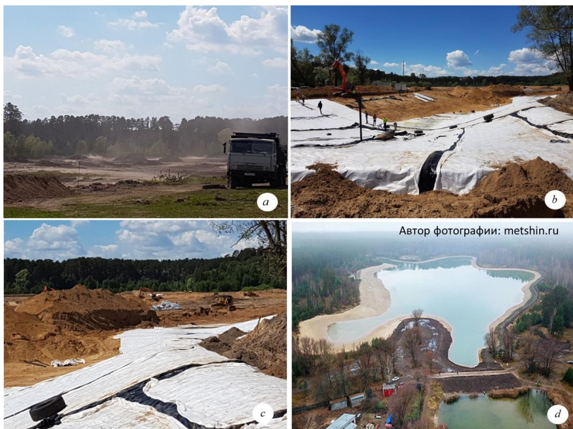
Рис. 1. Этапы выполнения работ по экореконструкции озер системы Лебязье a – углубление дна; b – гидроизоляция бентонитовыми матами; c – отсыпка слоя песка; d – заполнение озер водой.
